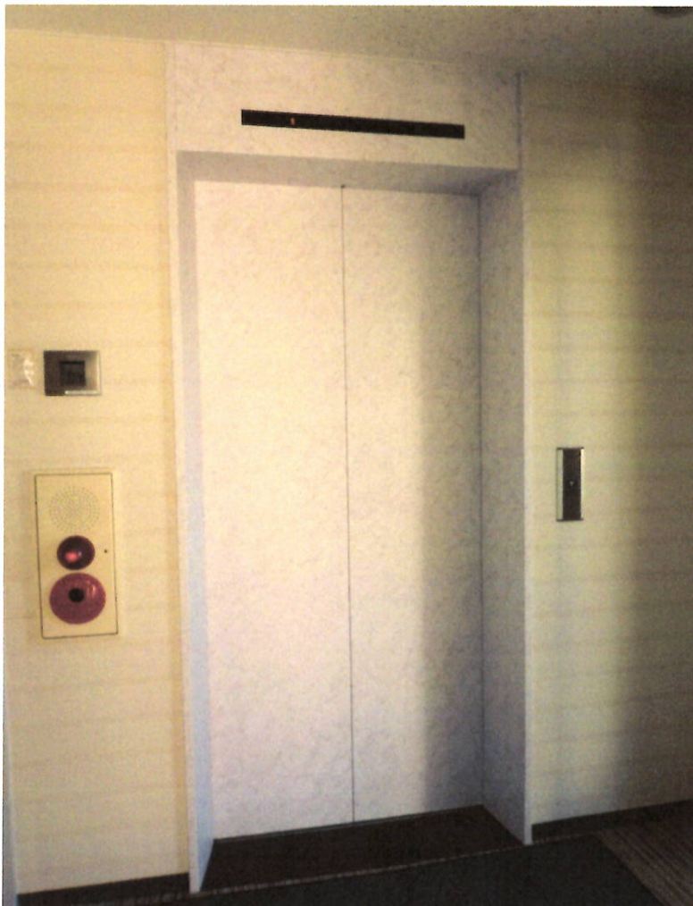
エレベーター扉ダイノック シート施工後
