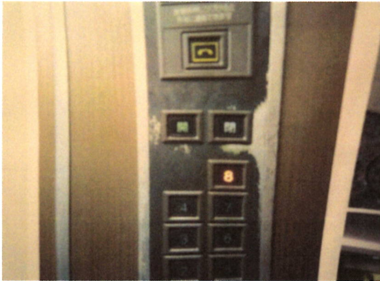
エレベータースイッチパネル 施工前
