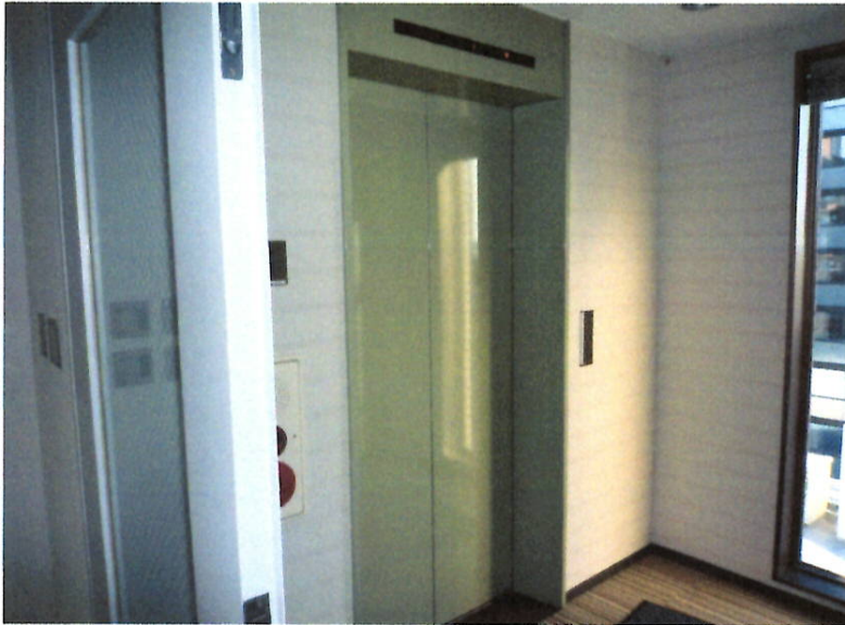
エレベーター扉施工前
