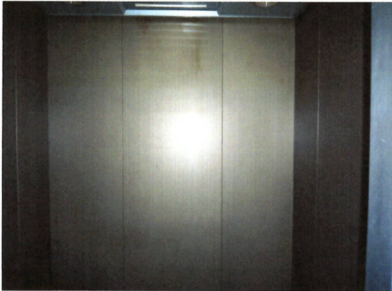
エレベーター内施工前 とても暗い印象です
