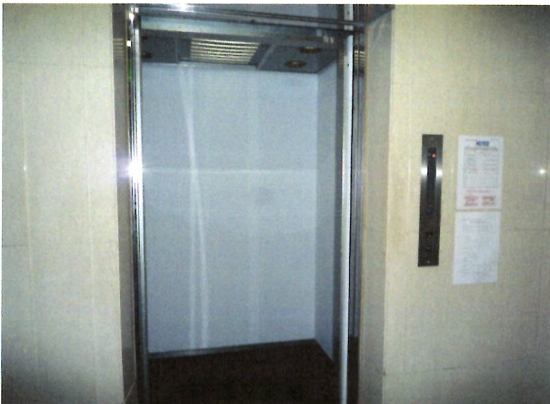
白色ダイノックシート施工後 照度は変わってませんがとても 明るくなりました。
