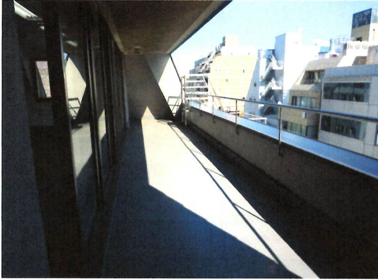
8Fバルコニー施工前
