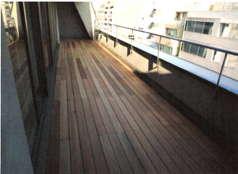
ウッドデッキ施工後
