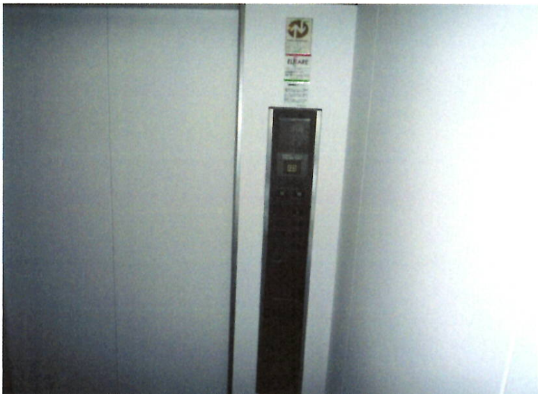
エレベータースイッチパネル 施工後 メーカーへ依頼し、スイッチ パネル専用シートでリニューアル しました。
