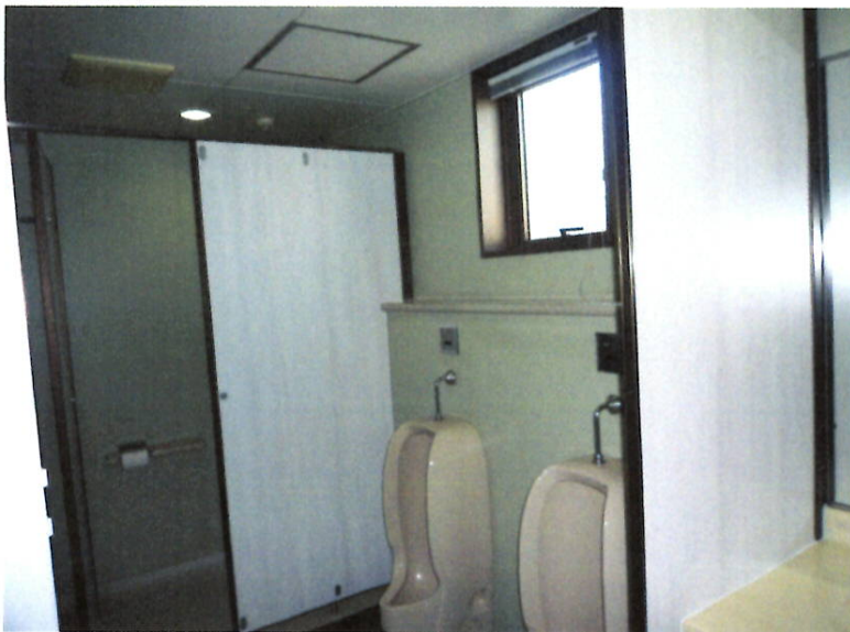
トイレブース施工後 白木目のダイノックシート
