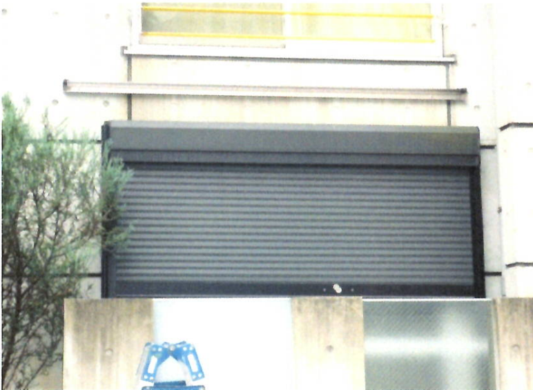
テラス屋根ベース設置
