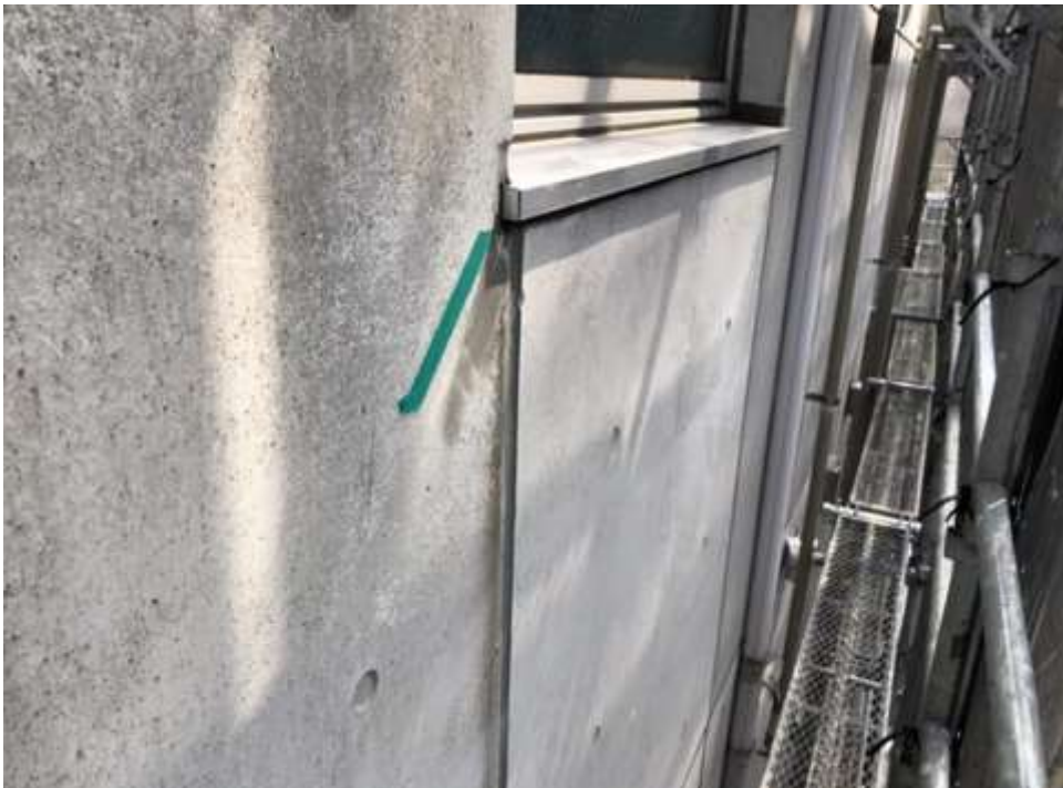
No. 1 打放しコンクリート 施工前
