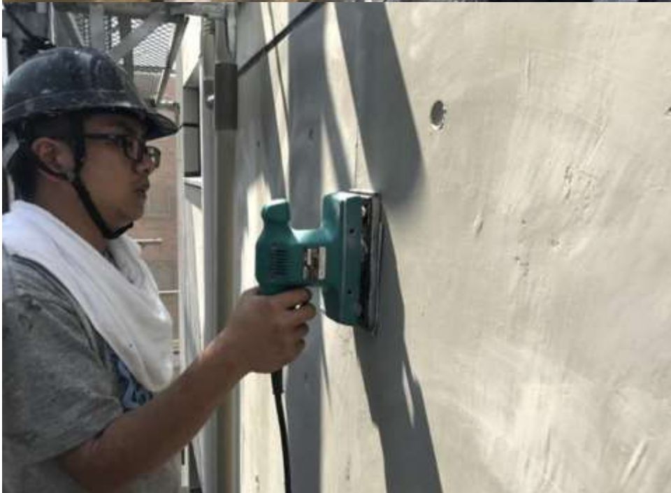
No. 3 打放しコンクリート ケレン
