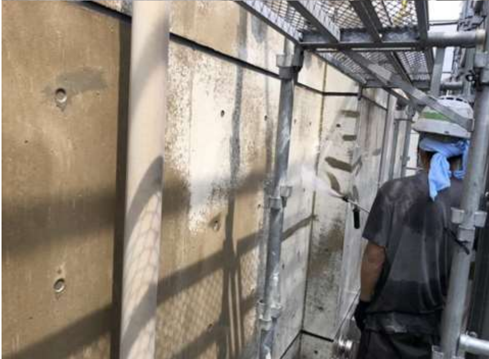
No. 2 打放しコンクリート 高圧水洗浄
