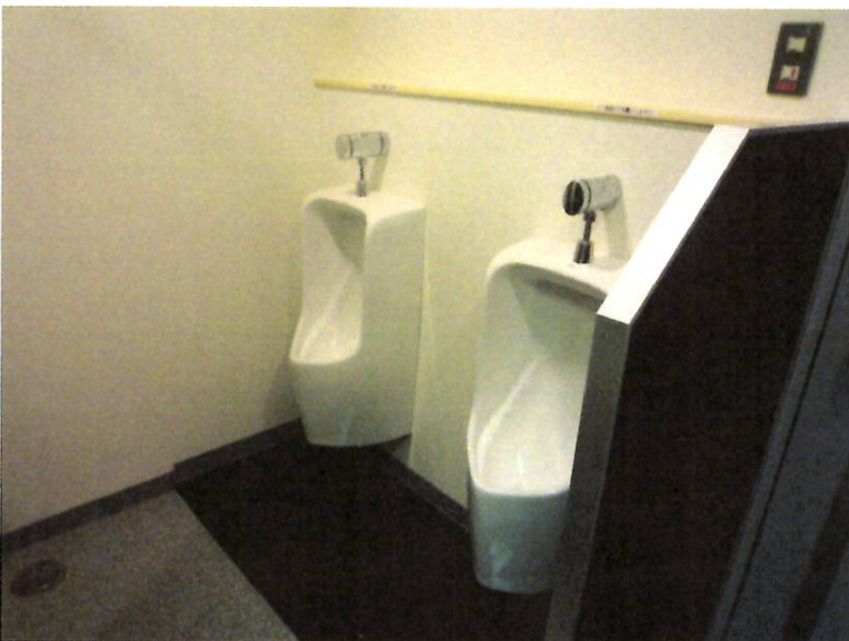
小便器改修後 クロス、床CF、ダイノック シート貼替済
